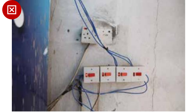
شكل رقم ٦: الأسلاك والأنابيب الخارجية المكشوفة
