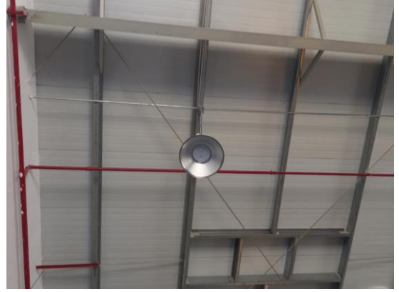
شكل رقم ١٧: سقف من الألواح المعدنية
