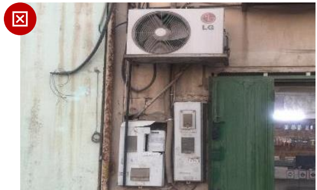
شكل رقم ٩: تركيب وحدات خارجية على واجهة الورشة
